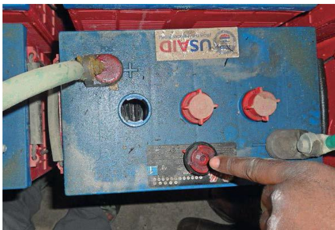
Figure 14 : Mise en place d'un bouchon de mesure de niveau en lieu et place d'un bouchon d'évaporation
