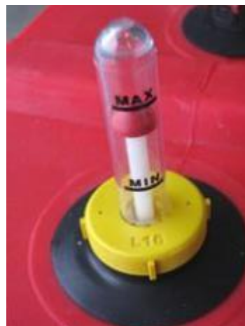
Figure 14 : Mise en place d'un bouchon de mesure de niveau en lieu et place d'un bouchon d'évaporation
