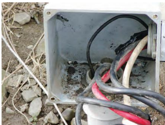
Figure 6 : Une boîte de jonction dans un "sale état"
