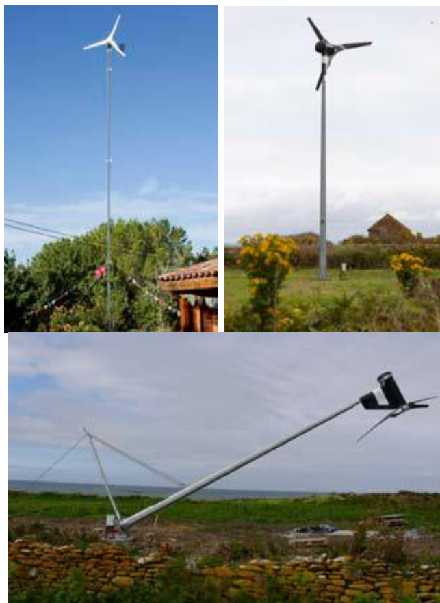
Figure 8 : Machine de marque Proven®, montée sur un mât autoporteur basculant en phase de levage
