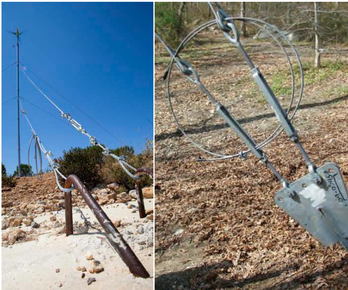
Figure 9 : Éléments constituant l'accastillage servant au maintien d'un mât haubané à la verticale
