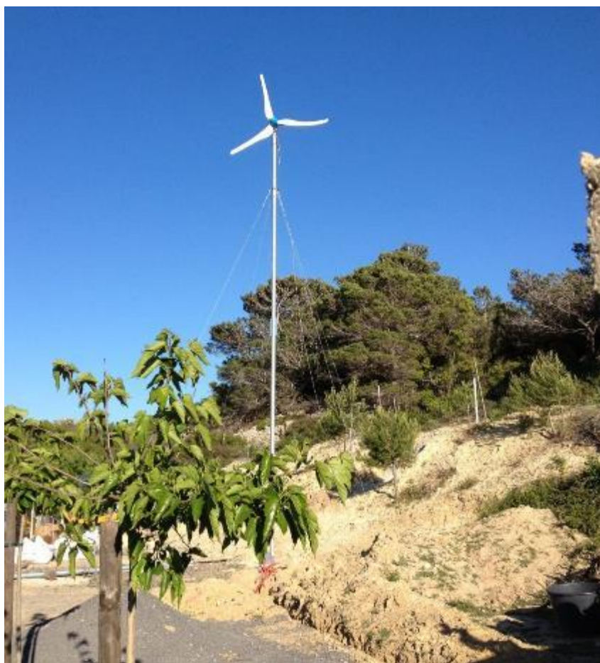
Figure 5 : Machine de marque Kestrel® montée sur un mât haubané
