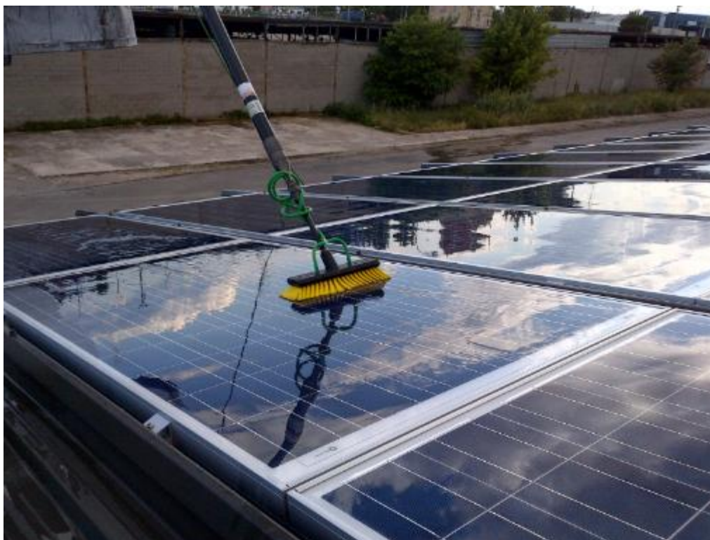
Figure 3 : Système de nettoyage de panneaux photovoltaïque
