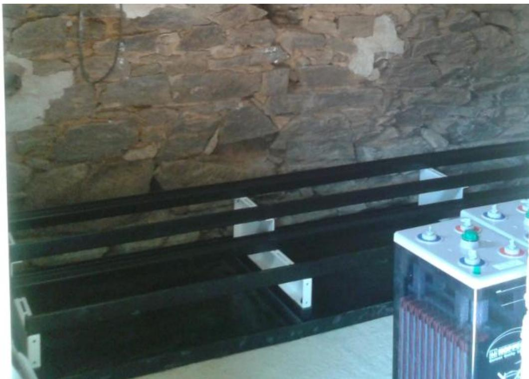
Figure 18 : Chantier métallique équipé d'un bac de rétention
