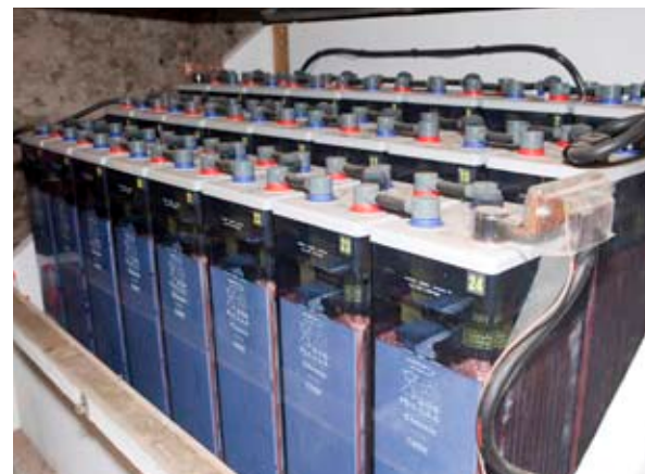
MAILLON FAIBLE D'UNE INSTALLATION EN SITE ISOLÉ: LA BATTERIE D'ACCUMULATEURS.
