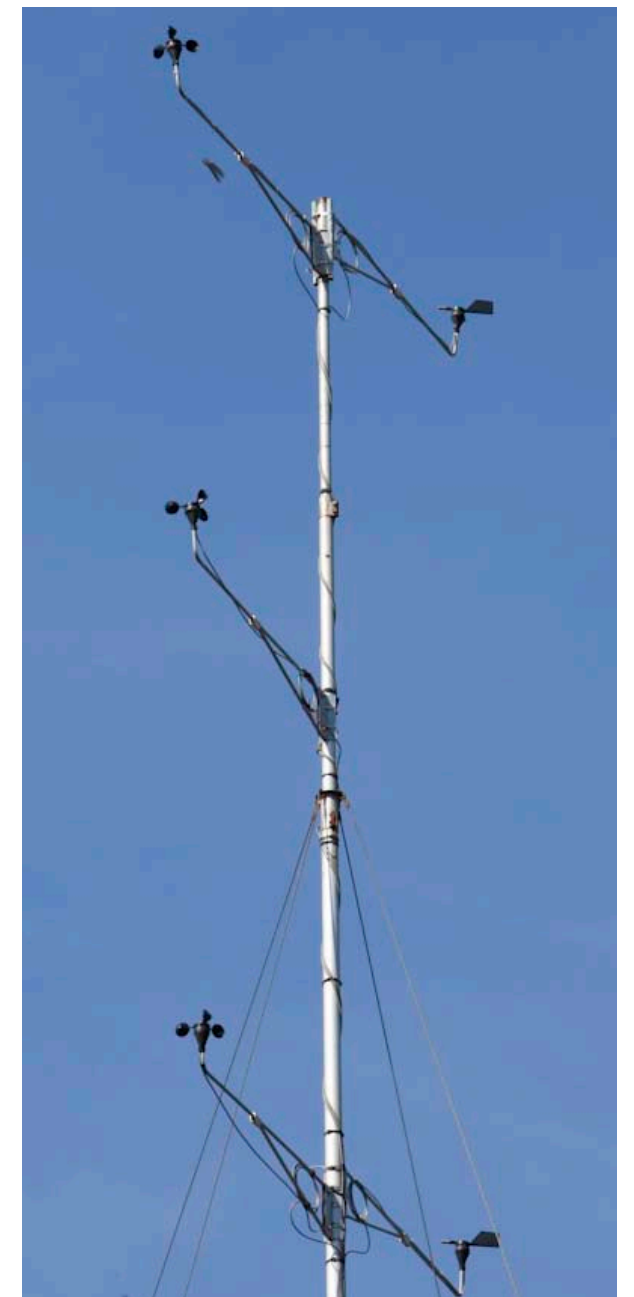
MÂT DE MESURE DE VENT ÉOLIEN.
