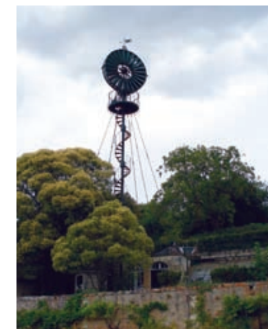
ÉOLIENNE BOLLÉE À PROXIMITÉ DE TOURS, EN BORD DE LOIRE.
