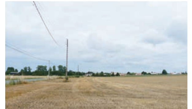
PROMISCUITÉ DES LIGNES ÉLECTRIQUES
