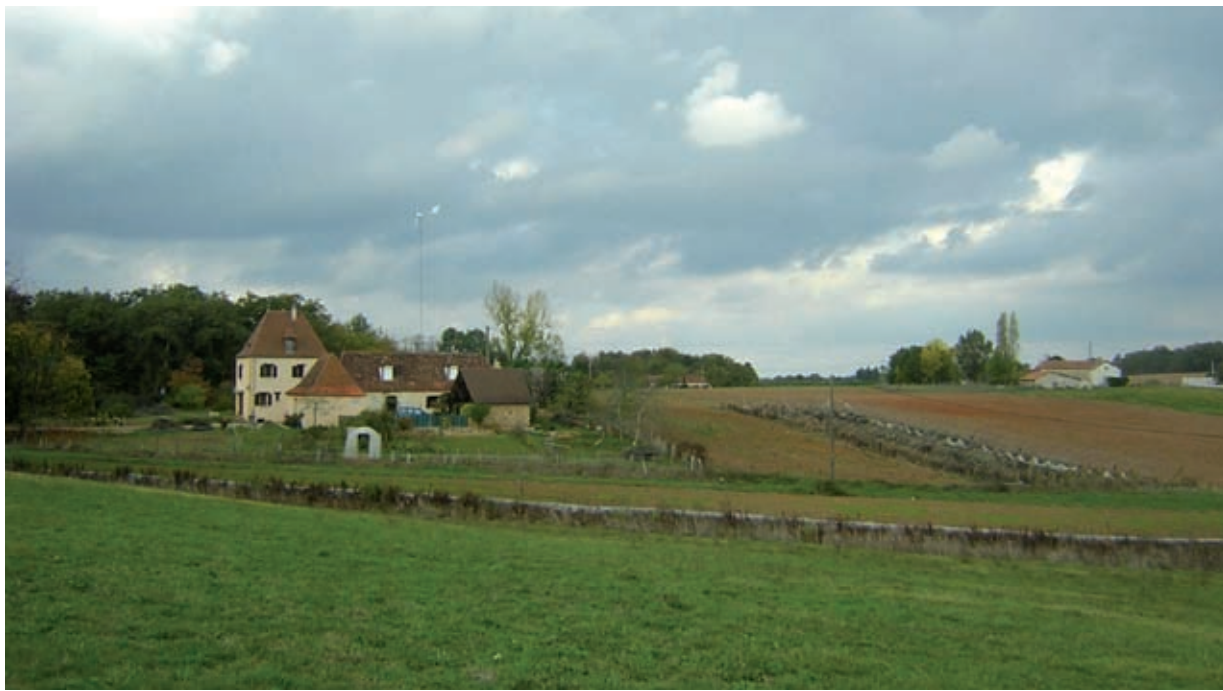
MALGRÉ UN MÂT À 24 MÈTRES DE HAUT, L'ÉOLIENNE N'ÉMERGE PAS SUFFISAMMENT AU-DESSUS DES OBSTACLES ENVIRONNANT, D'OÙ UNE PRODUCTION DÉCEVANTE.
