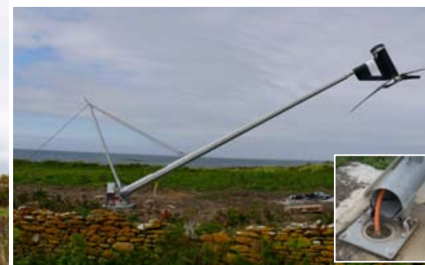
MÂT AUTOPORTANT BASCULANT.
