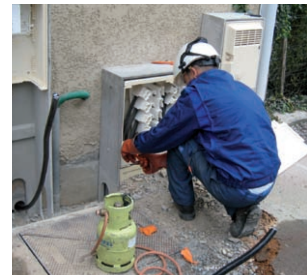
LE RACCORDEMENT DE L'ÉOLIENNE PEUT ÊTRE RÉALISÉ EN LIMITE DE PROPRIÉTÉ OU SUR LE TERRAIN, AVEC UN MAXIMUM DE 30 M.
