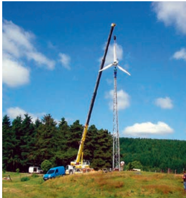
LORS DU MONTAGE DE L'AÉROGÉNÉRATEUR 10KW AIRCON.
